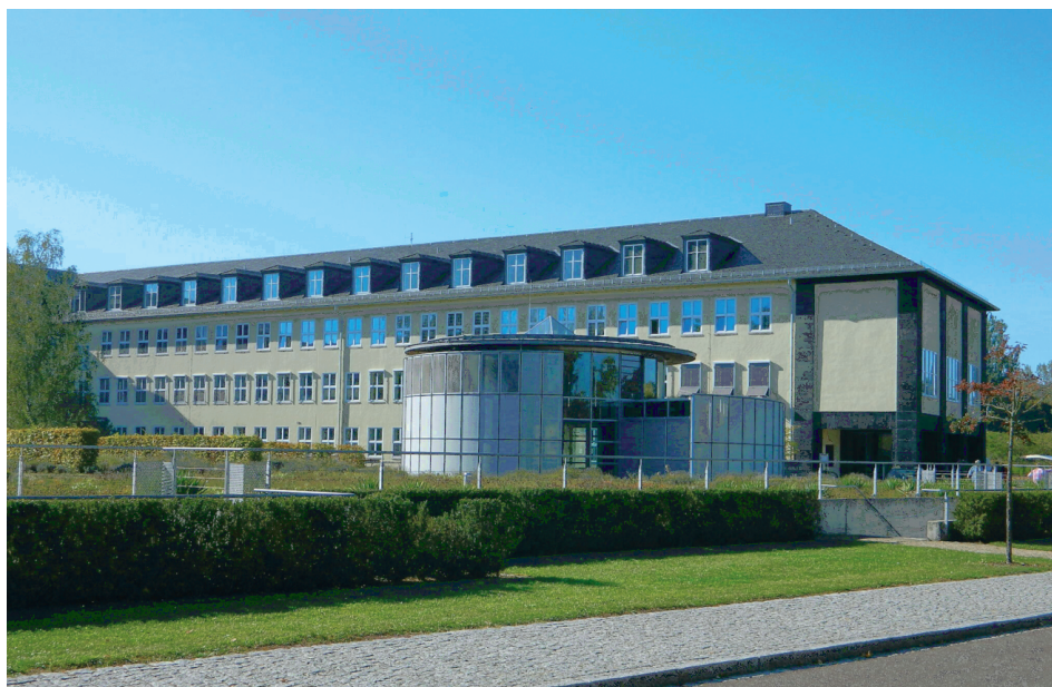
Ehrgeizige Ziele sind erreichbar: Eine wichtige Säule für das Wachstum der EVH in Halle ist der Ausbau von Contracting. Einer der Kunden ist das Krankenhaus Martha-Maria in Halle-Dölau. Bild: EVH
